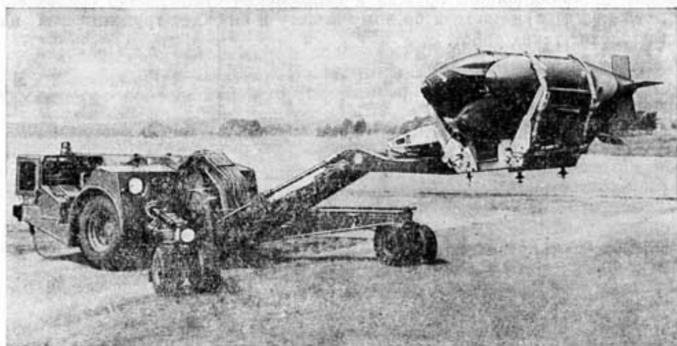
Рис. 3. Английский аэродромный автопогрузчик фирмы «Эр-Лог» Фото из журнала «Хидраулик энд эр инджиниринг»
